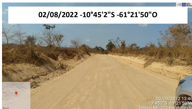
FOTO 10: VISTA AO LONGO DO TRECHO – KM 55
