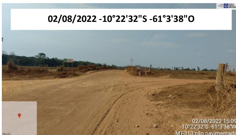
FOTO 19: VISTA AO LONGO DO TRECHO MT-313
