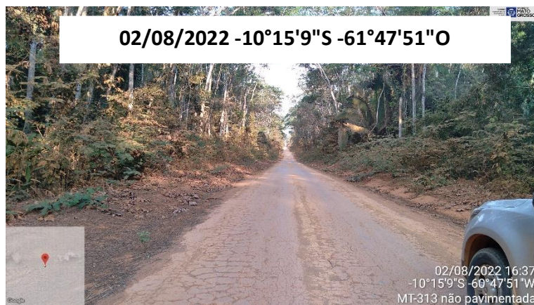
FOTO 32: VISTA AO LONGO DO TRECHO MT-313
