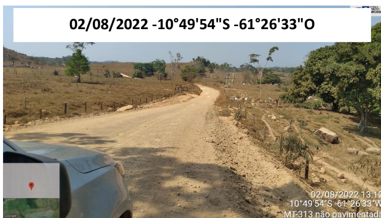
FOTO 02: VISTA INÍCIO DO TRECHO – KM 0
