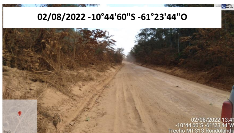
FOTO 08: VISTA INÍCIO DO TRECHO – KM 20
