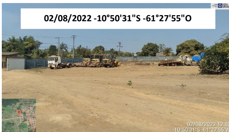
FOTO 01: PATIO DE EQUIPAMENTOS – KM 0
