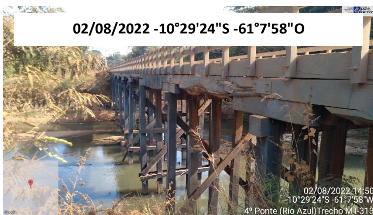
FOTO 15: VISTA PONTE DE MADEIRA, RIO AZUL
