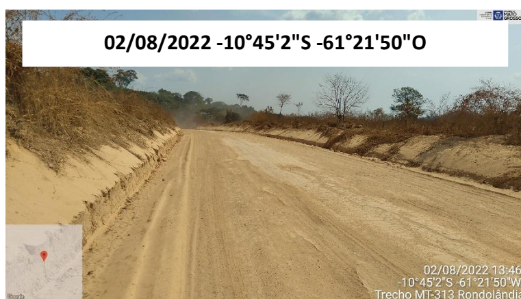
FOTO 09: VISTA AO LONGO DO TRECHO – KM 50
