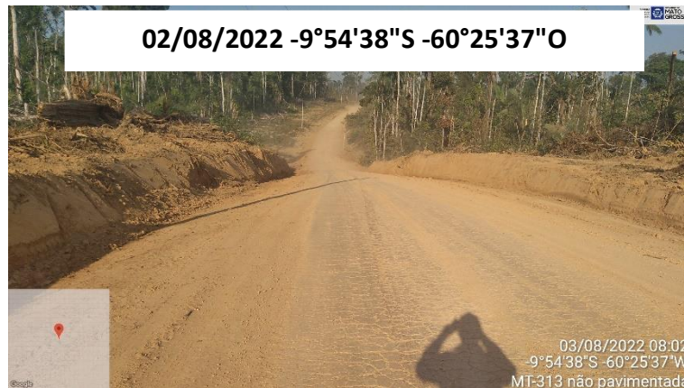
FOTO 50: VISTA AO LONGO DO TRECHO MT-313
