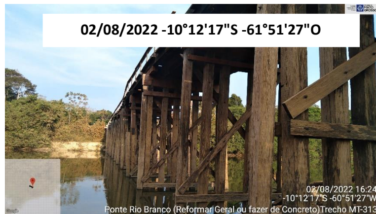
FOTO 29: VISTA PONTE DE MADEIRA SOBRE O RIO BRANCO
