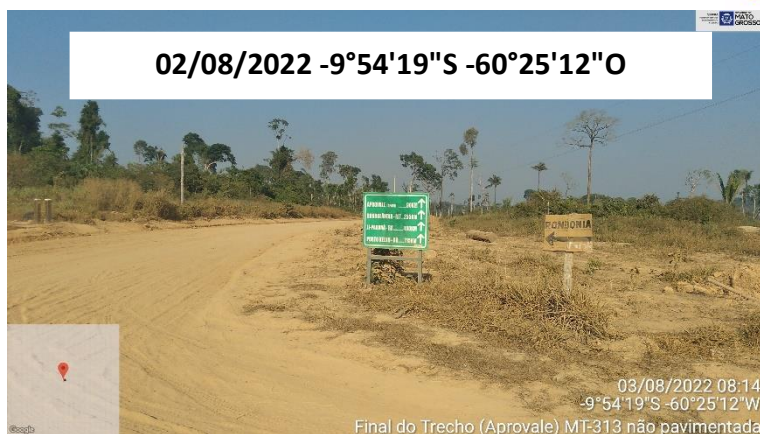
FOTO 52: FINAL DO TRECHO (APROVALE) MT-313
