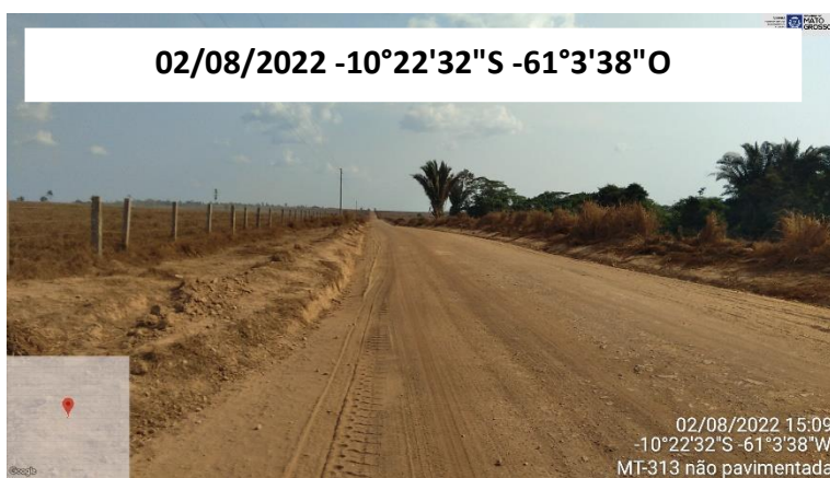
FOTO 20: VISTA AO LONGO DO TRECHO MT-313
