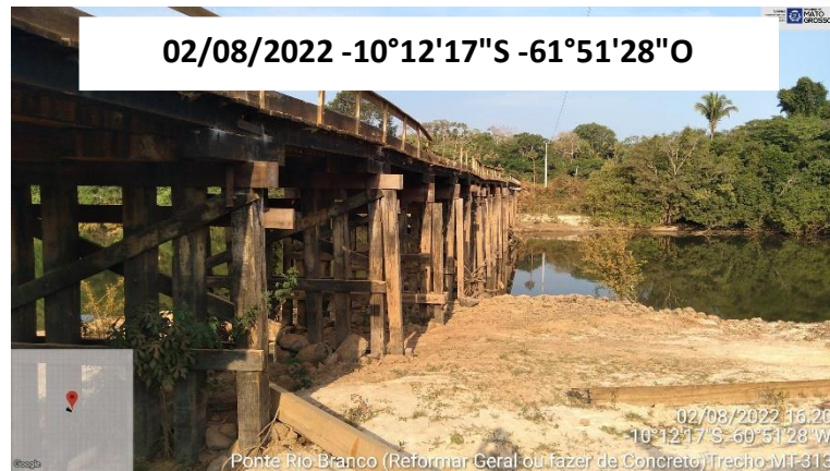
FOTO 28: VISTA PONTE DE MADEIRA SOBRE O RIO BRANCO
