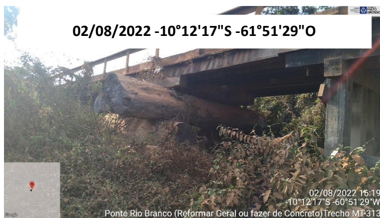
FOTO 26: VISTA PONTE DE MADEIRA SOBRE O RIO BRANCO
