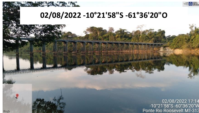
FOTO 37: PONTE DE MADEIRA SOBRE O RIO ROOSEVELT
