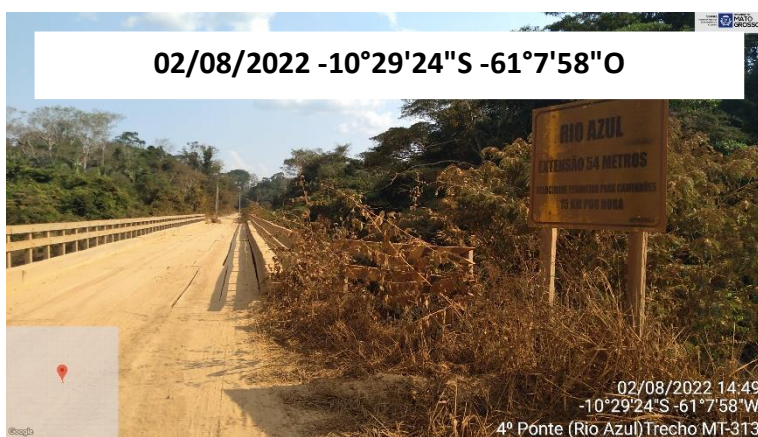
FOTO 14: VISTA PONTE DE MADEIRA, RIO AZUL
