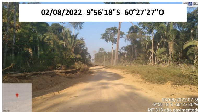
FOTO 49: VISTA AO LONGO DO TRECHO MT-313
