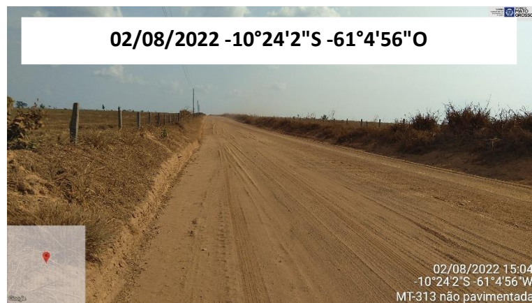
FOTO 17: VISTA AO LONGO DO TRECHO MT-313
