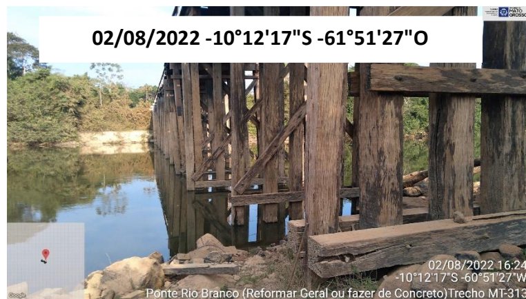
FOTO 30: VISTA PONTE DE MADEIRA SOBRE O RIO BRANCO
