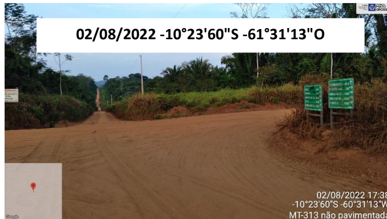
FOTO 40: VISTA AO LONGO DO TRECHO MT-313
