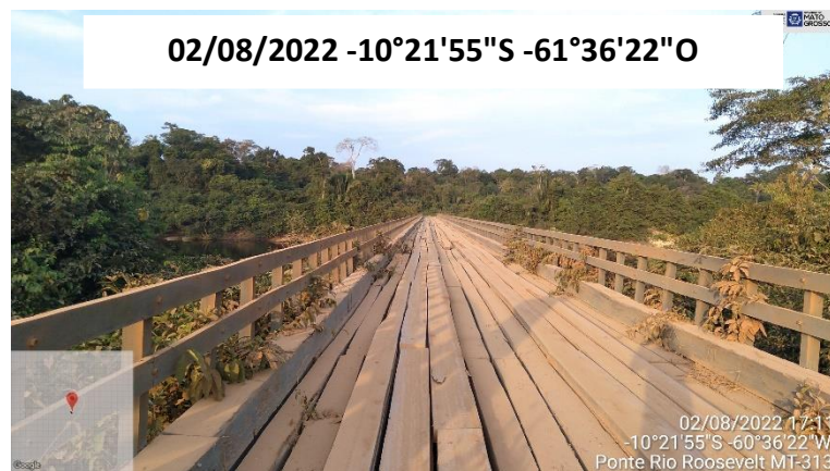
FOTO 36: PONTE DE MADEIRA SOBRE O RIO ROOSEVELT
