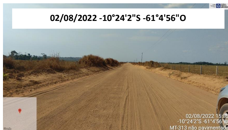
FOTO 18: VISTA AO LONGO DO TRECHO MT-313
