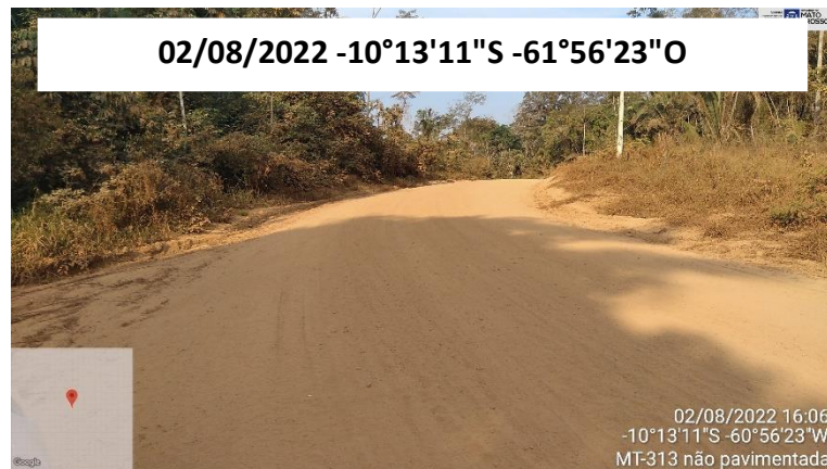
FOTO 23: VISTA AO LONGO DO TRECHO MT-313
