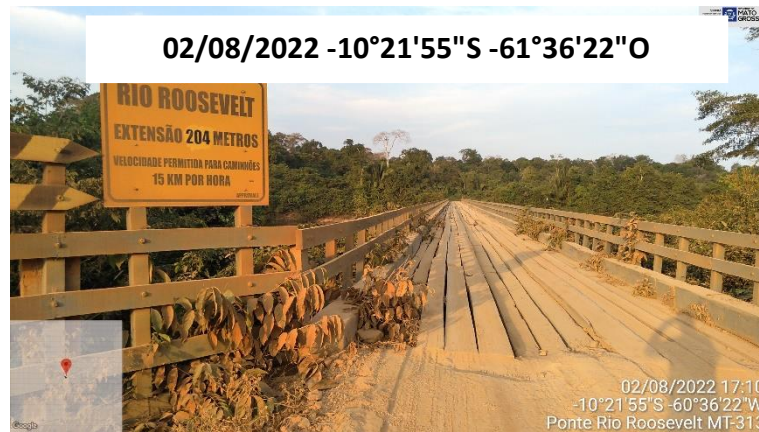
FOTO 35: PONTE DE MADEIRA SOBRE O RIO ROOSEVELT
