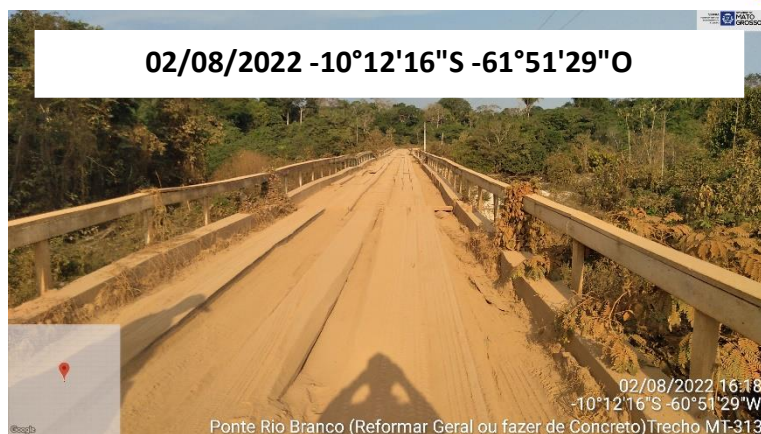
FOTO 25: VISTA PONTE DE MADEIRA SOBRE O RIO BRANCO
