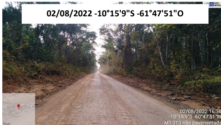
FOTO 31: VISTA AO LONGO DO TRECHO MT-313
