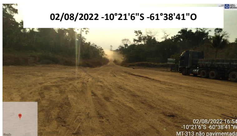
FOTO 33: VISTA AO LONGO DO TRECHO MT-313
