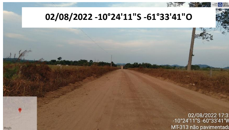
FOTO 38: VISTA AO LONGO DO TRECHO MT-313
