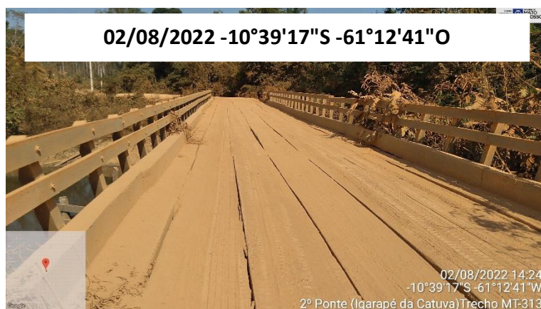
FOTO 12: VISTA PONTE DE MADEIRA, IGARAPÉ DA CATUVA
