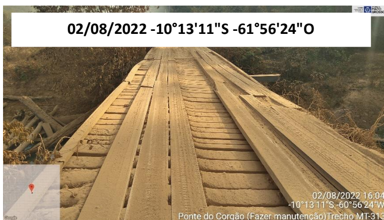
FOTO 21: VISTA PONTE SOBRE O RIO CORGÃO
