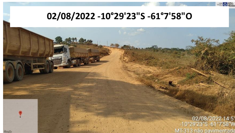
FOTO 16: VISTA AO LONGO DO TRECHO MT-313
