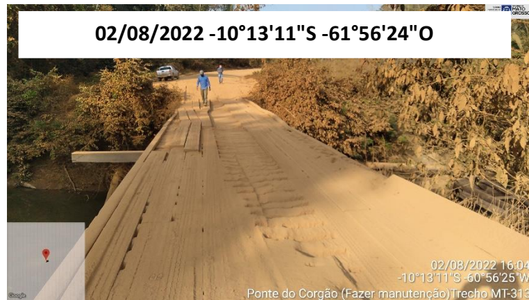
FOTO 22: VISTA PONTE SOBRE O RIO CORGÃO
