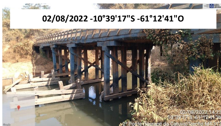
FOTO 11: VISTA PONTE DE MADEIRA, IGARAPÉ DA CATUVA
