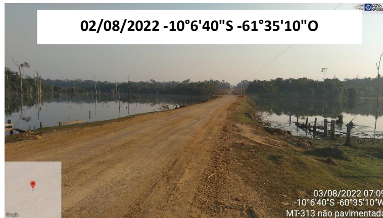
FOTO 43: VISTA AO LONGO DO TRECHO MT-313
