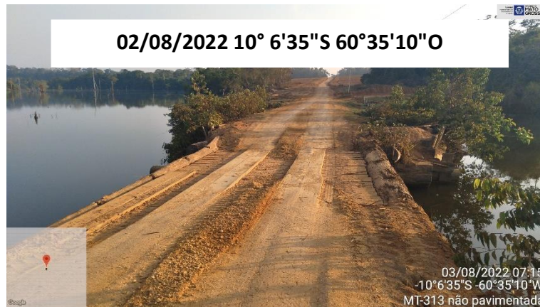
FOTO 44: VISTA PONTE DE MADEIRA
