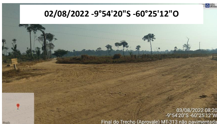
FOTO 53: FINAL DO TRECHO (APROVALE) MT-313
