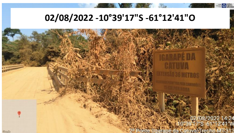
FOTO 13: VISTA PONTE DE MADEIRA, IGARAPÉ DA CATUVA
