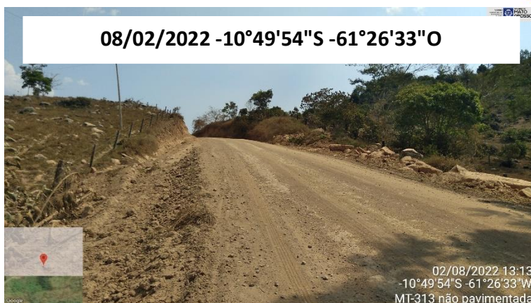
FOTO 04: VISTA INÍCIO DO TRECHO – KM 3
