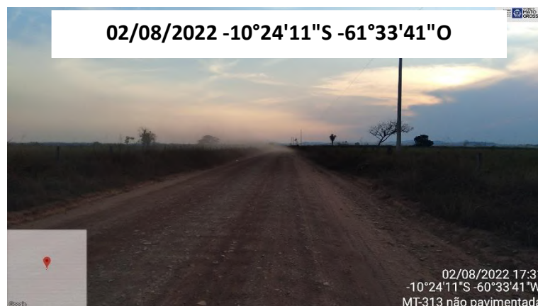
FOTO 39: VISTA AO LONGO DO TRECHO MT-313
