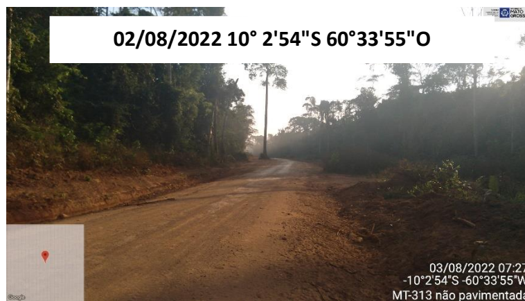
FOTO 45: VISTA AO LONGO DO TRECHO MT-313
