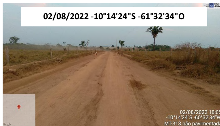
FOTO 42: VISTA AO LONGO DO TRECHO MT-313
